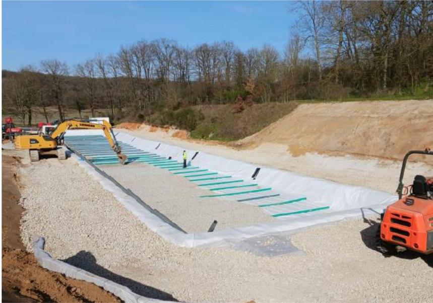
Pose du système de drainage et début du remplissage du 1<sup>er</sup> étage
