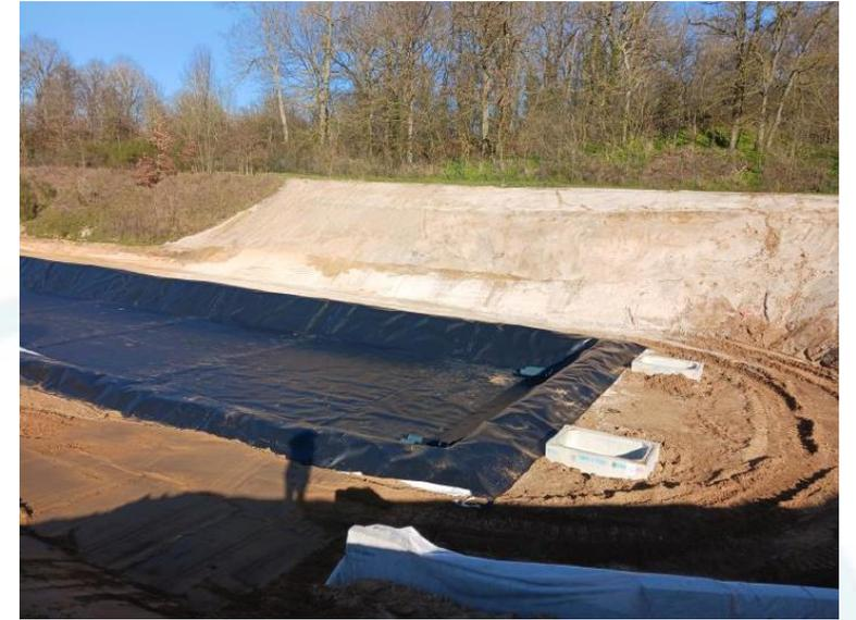
Pose de la géomembrane du 1<sup>er</sup> étage
