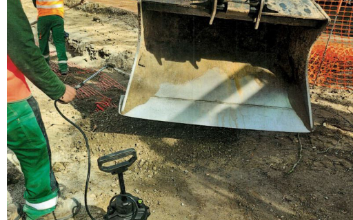
Désinfection post chantier (source Eurovia)
